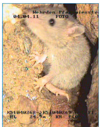
Schädlinge als Folge von defekten Kanälen
