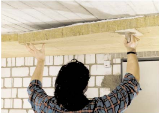
Abbildung 6: Anbringen Dämmung Kellerdecke
