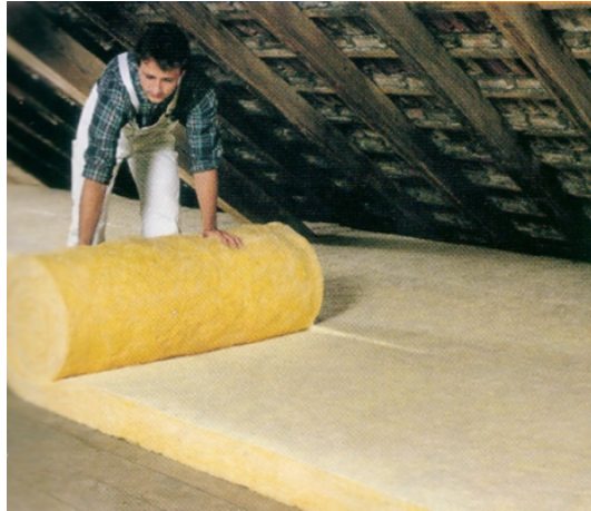
Abbildung 5: Anbringen Dämmung oberste Geschossdecke
